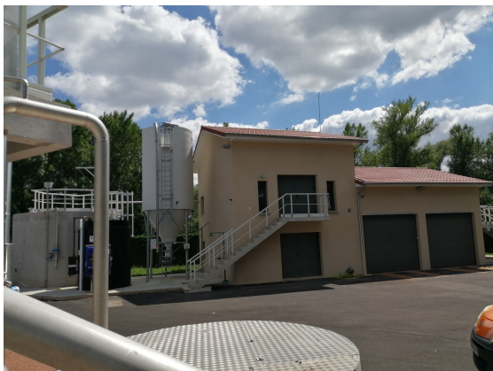
Bâtiment traitement des boues Pouilly
